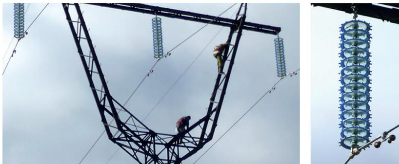
*Рисунок 29. ВЛ 220 кВ «Цимлянская ГЭС – Шахты 30», оснащённая ГИРМК.*
