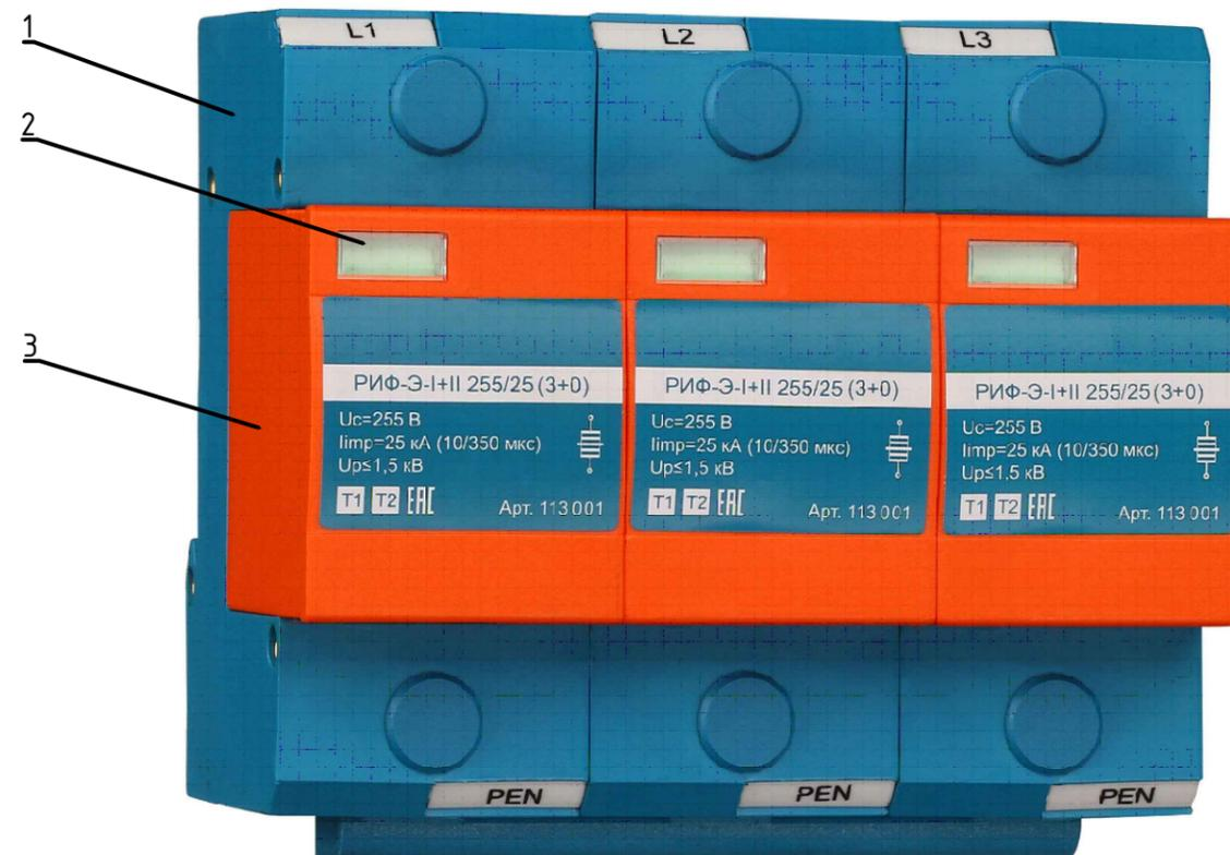
Устройство защиты от импульсных перенапряжений (УЗИП) коммутующего типа РИФ-Э-1+II 255/25 (3+0) предназначено для защиты оборудования в низковольтных цепях до 1000 В от вторичных воздействий молнии, электромагнитных наводок и коммутационных перенапряжений. Применяется в системе заземления TN-C. Трехполюсное УЗИП класса испытаний I+II состоит из базы и трех сменных рабочих модулей. УЗИП устанавливается на стандартную DIN-рейку
