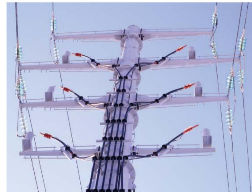
Рис. 2. Кабельная лестница и концевые муфты на ПКПО-КВ-35
