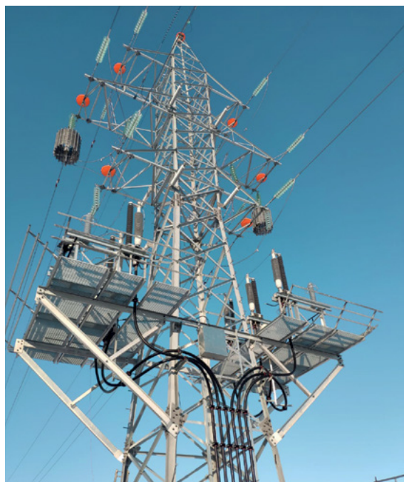
Переходной пункт ПКПО-АКЭП-110.2-2.1 с эксплуатационными площадками, г. Воронеж
