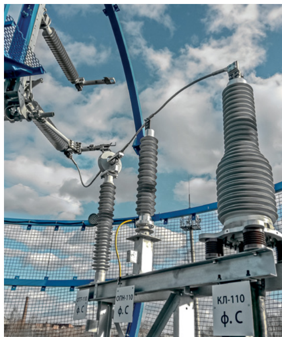
Основное оборудование ППМ: на стойке размещены сухая кабельная муфта, ОПН и электронный оптический трансформатор тока; вертикальные однофазные разъединители расположены на стволе опоры
