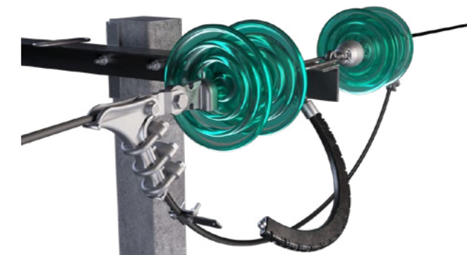
Рис. 9. Установка РМКЭ-10 совместно с натяжной стеклянной изоляцией
