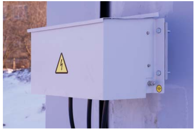
Рис. 4. Концевая коробка заземления экранов кабелей
