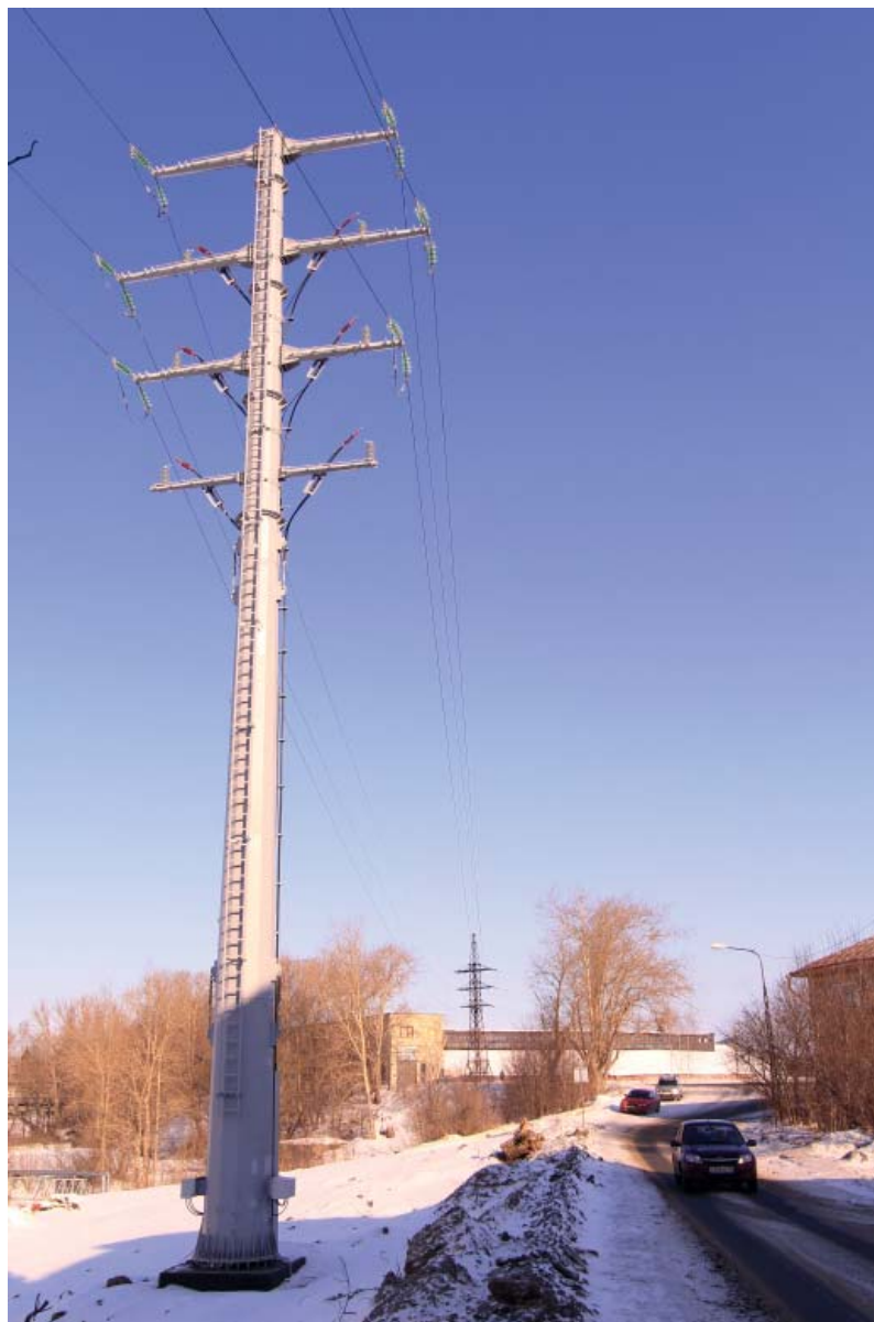
Рис. 5. ПКПО-КВ-35 в г. Петрозаводске (монтаж не завершен)
