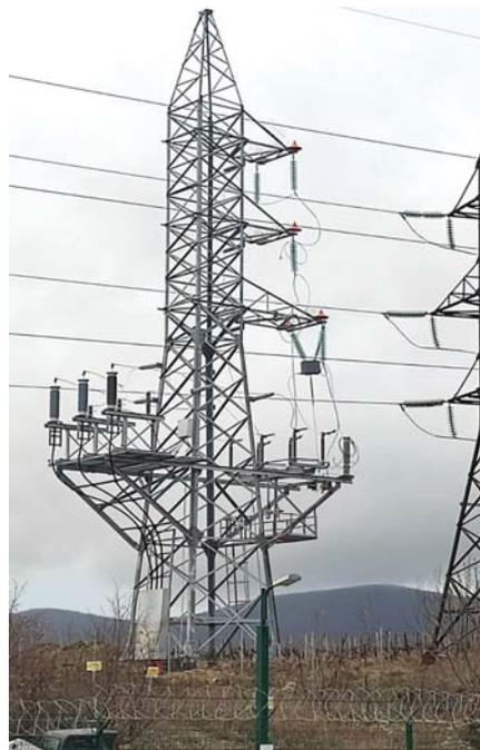
Рис. 3. Переходной пункт ПКПО-АКЭП-110.2-1.1-1 на решетчатой опоре с двумя площадками анфас
