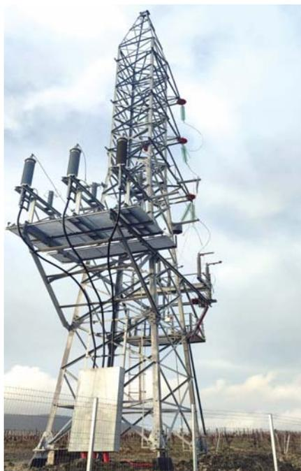
Рис. 2. Переходной пункт ПКПО-АКЭП-110.2-1.1-1 на решетчатой опоре с двумя площадками в профиль
