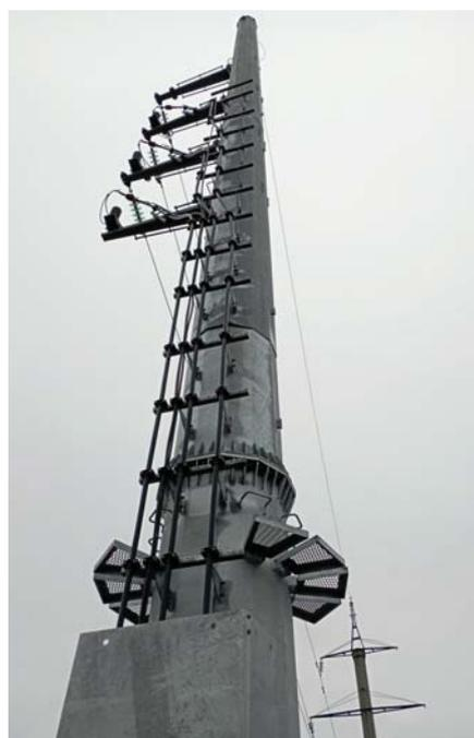
Рис. 1. Переходной пункт ПКПО-КВ-35.1-1.1+5В на многогранной опоре с односторонним расположением траверс
