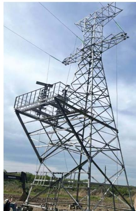
Рис. 4. Переходной пункт ПКПО-АКЭП-220 на решетчатой опоре с эксплуатационной площадкой
