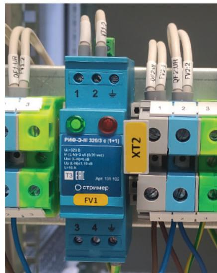
Рис. 1. Монтаж УЗИП на DIN-рейку
