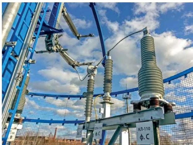
Рис. 2. Основное электротехническое оборудование ППМ-110: вертикальный однофазный разъединитель, оптический трансформатор тока, ОПН, концевая кабельная муфта
