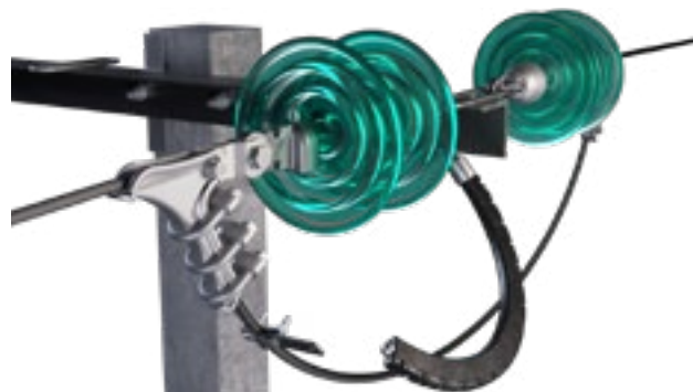
Рис. 9. Установка РМКЭ-10 совместно с натяжной стеклянной изоляцией
