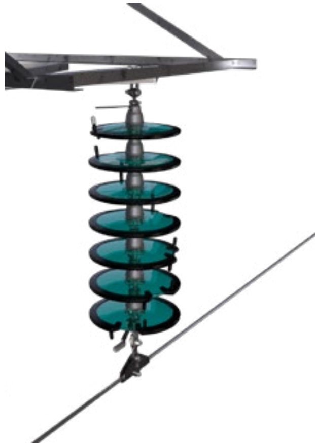
Рис. 25. Установка гирлянды ГИРМК-110 на промежуточной опоре
