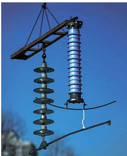
Рис. 8. Проверка возможности защиты изоляторов от перекрытий
