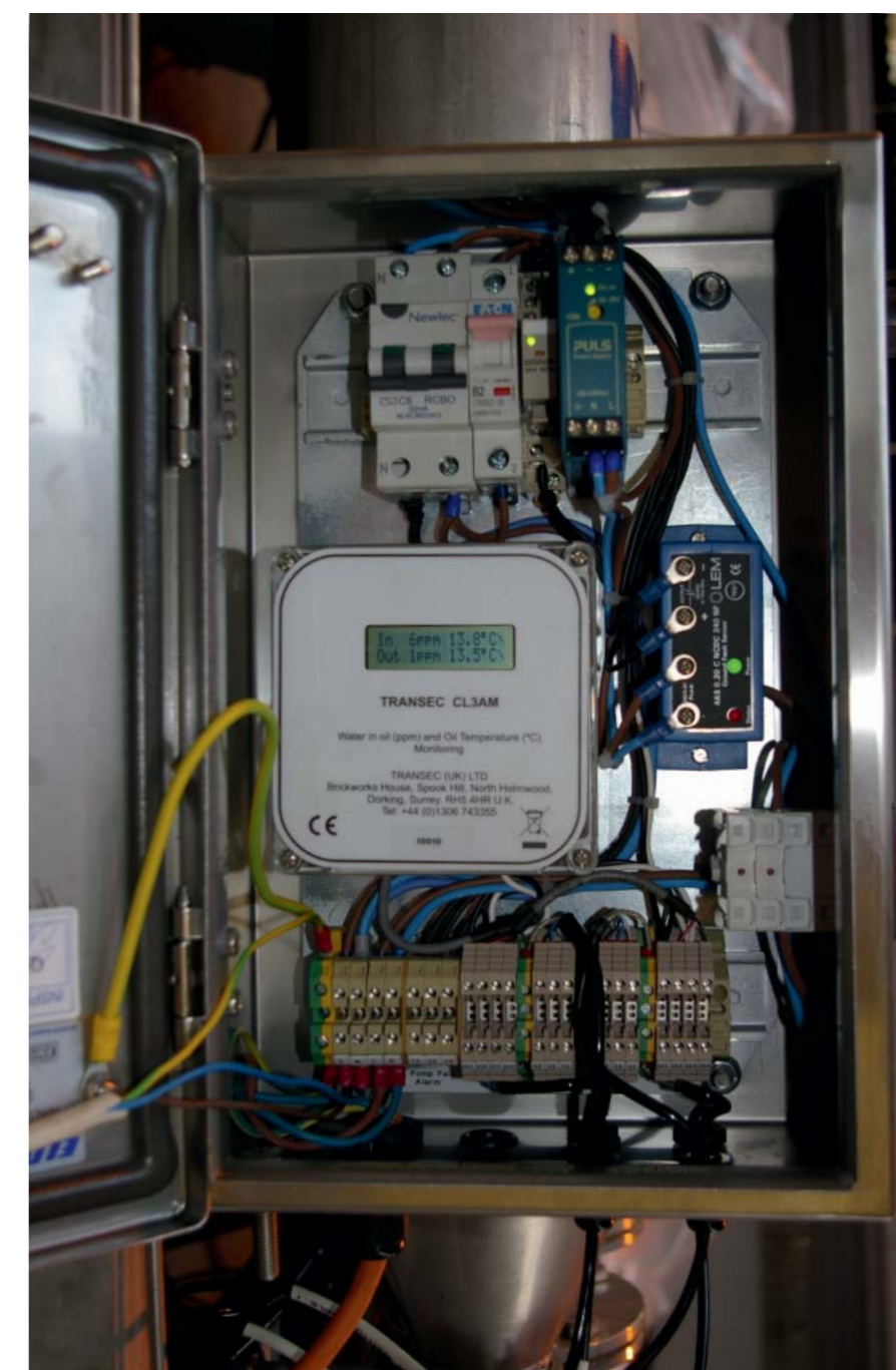
Рис. 2. Блок мониторинга осушителя TRANSEC
