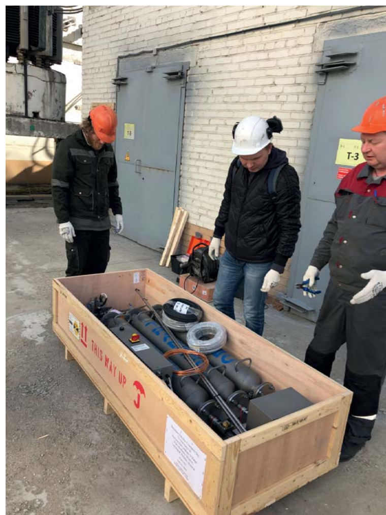
Рис. 4. Монтаж осушителя TRANSEC на ПС «Чертаново»
