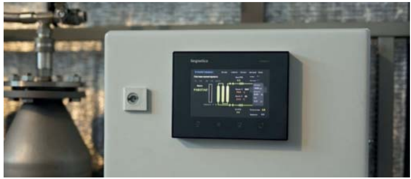
Рис. 5. Дисплей системы мониторинга АСУ СИТО «TRANSEC»
