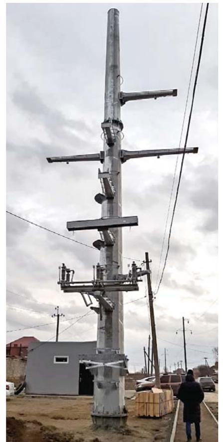
Рис. 3. Монтаж переходного пункта на многогранной опоре с разъединителем
