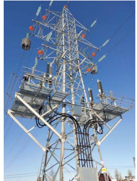
Рис. 2. Специальные площадки для обслуживания оборудования на двухцепном переходном пункте на решетчатой опоре
